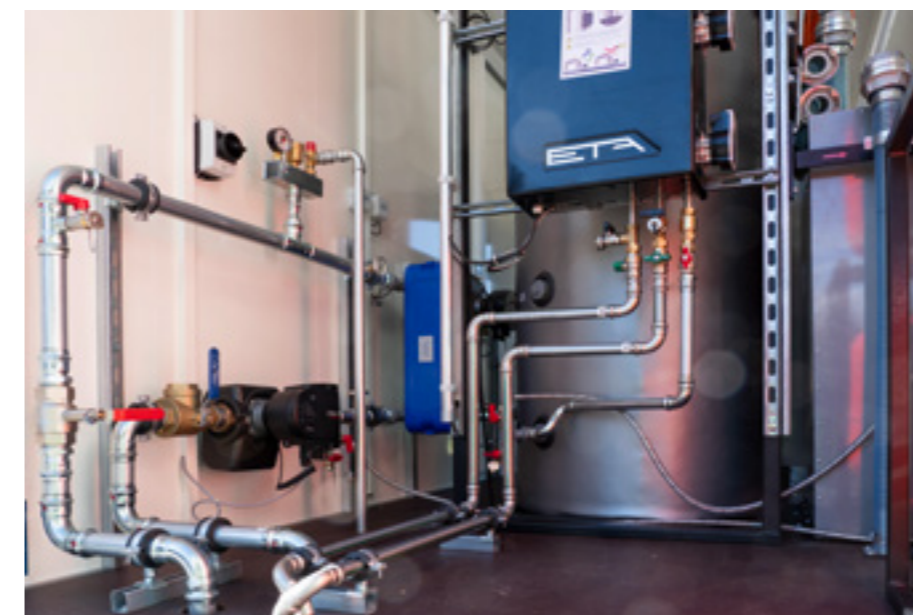
Links die mit einem Wärmetauscher getrennte Heizgruppe und rechts im Bild das Frischwassermodul für die Warmwasseraufbereitung.
